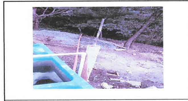
Foto 6: Sustitucion de pilas
