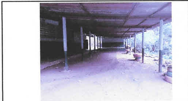
Foto 1: Sustitucion de Torta de cemento
