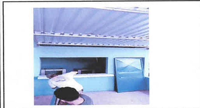
Foto 3: Remodelacion de Cocina
