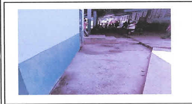
Foto 5: Sustitucion de banqueta
