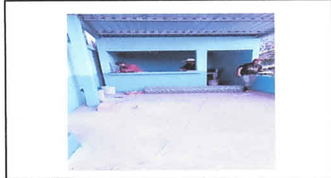
Foto 4: Sustitucion de polleton y torta de cemento
