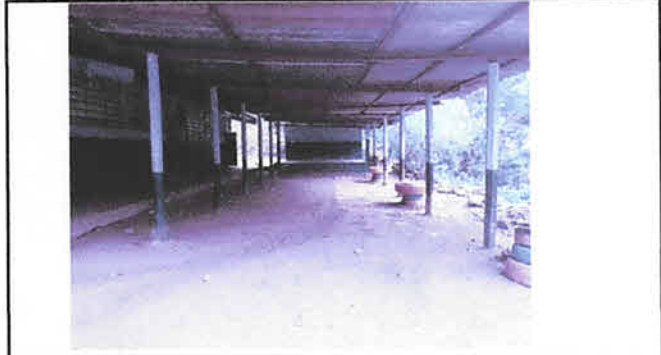
Foto 2: Remodelacion de Escenario
